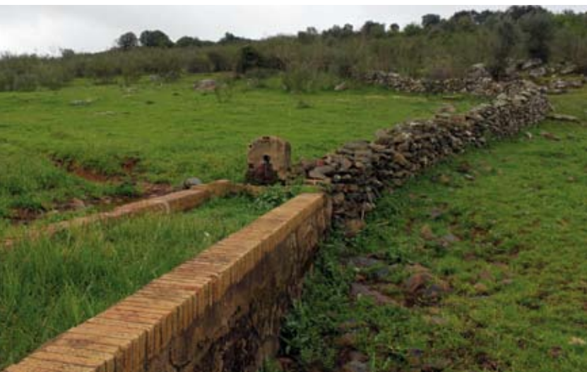
Fuente con pilar en el barranco de las Cañadas
